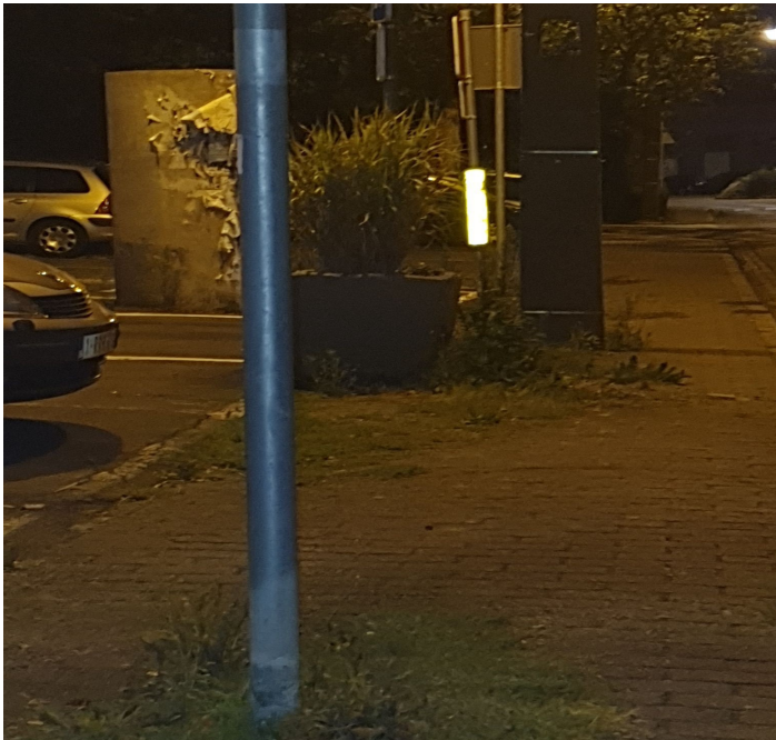
Un trottoir parmi tant d'autres dans le même état.
